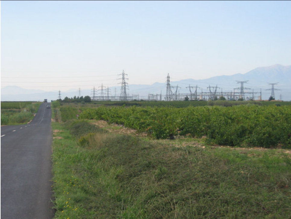
Figure 6 : Le poste de Baixas sur le plateau, vu de la route provenant du village de Baixas
