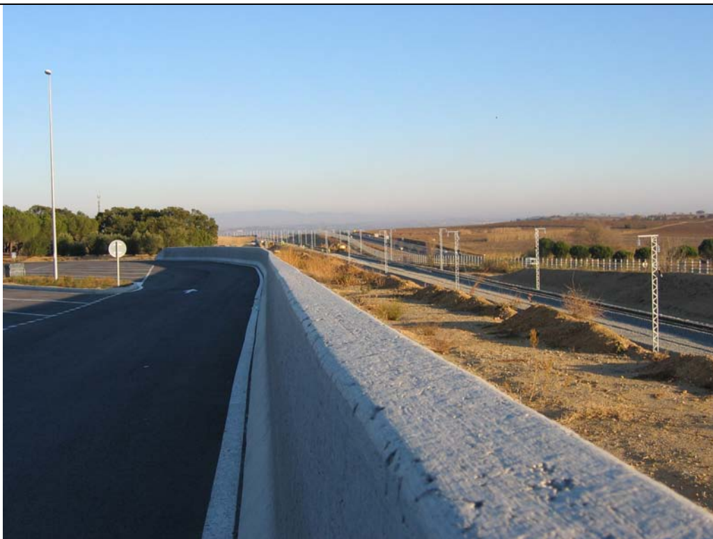
Figure 19 : L'aire du Village Catalan, où autoroute, LGV et D 900 se côtoient
