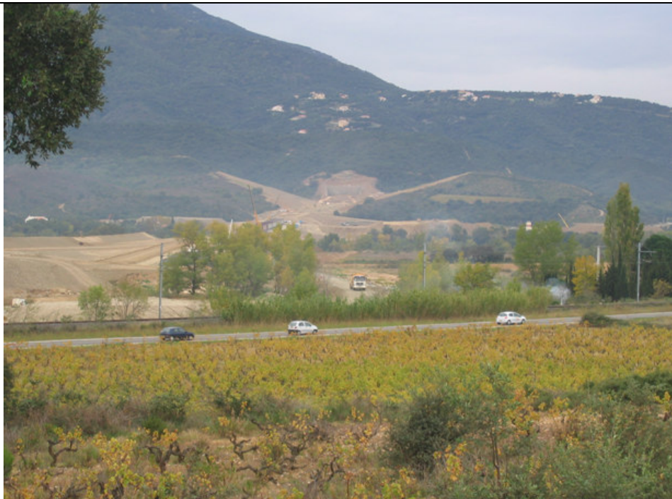
Figure 7 : L'entrée du tunnel LGV, côté France
